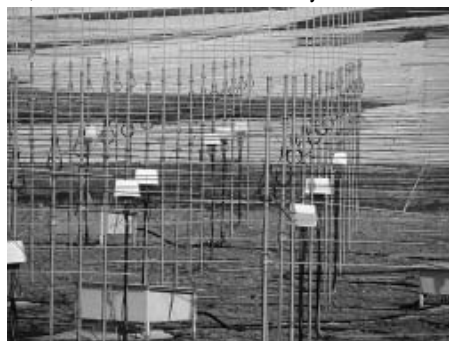
SOUSY – SVALBARD Radar – SSR
