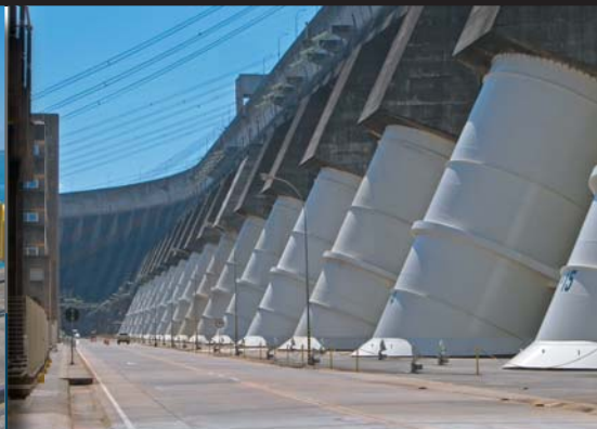
Hydroelektrárna Itaipu - bílé roury jsou přívodní potubí (průměr roury 8m) k jednotlivým turbínám
