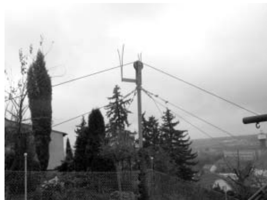
Obr. 3. Kotvená „jehla“ pro zdvímání stožáru
