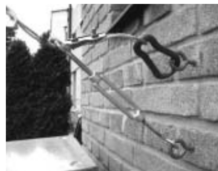
Obr. 10. Příklad kotvení napínačem jištěným karabinou
