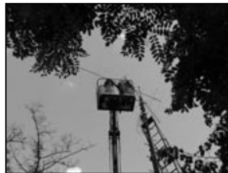
Montáž nezávislého otáčení souose uchycených antén pro dvě pásma
