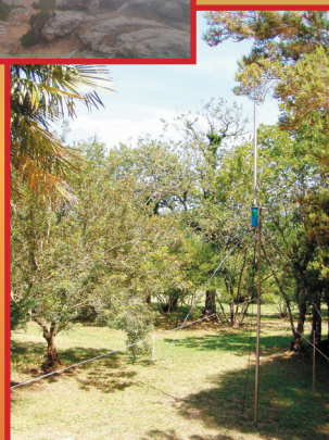
Nenápadně instalovaný KV vertikál
