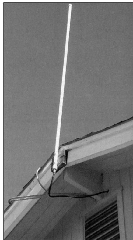
Obr. 3. Hotová anténa upevněná na střeše
